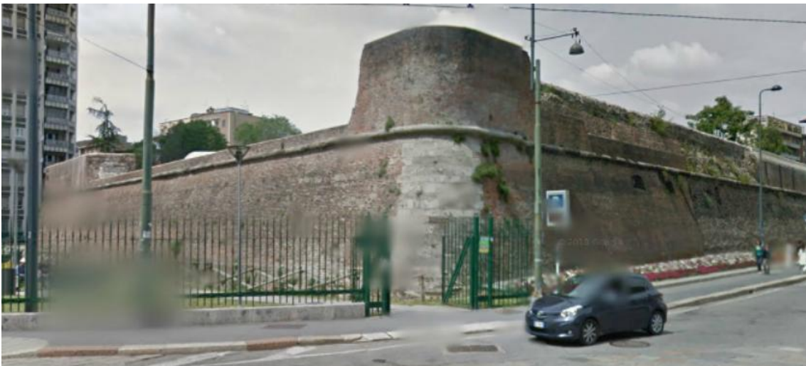
Tratto murario di via Sabotino
