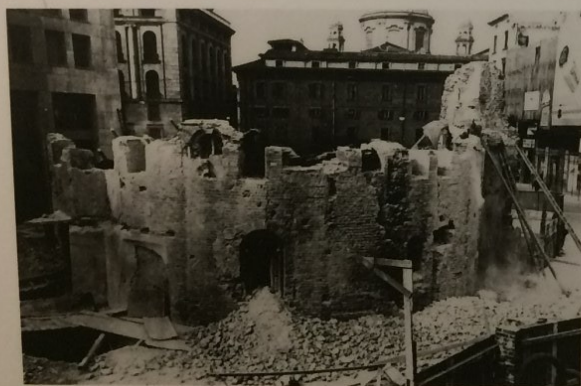
3. La chiesa durante gli interventi di demolizione (1948-1952) (Civico Archivio Fotografico, Milano).
